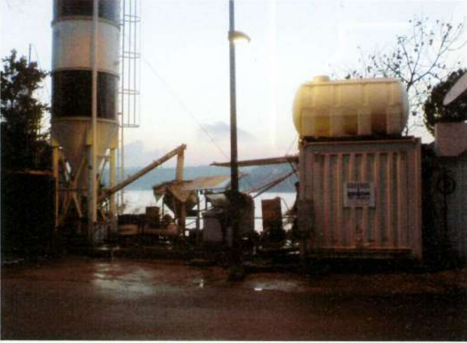
Resim 3: Çimento silosu, mikser ve jet-grout pompası
