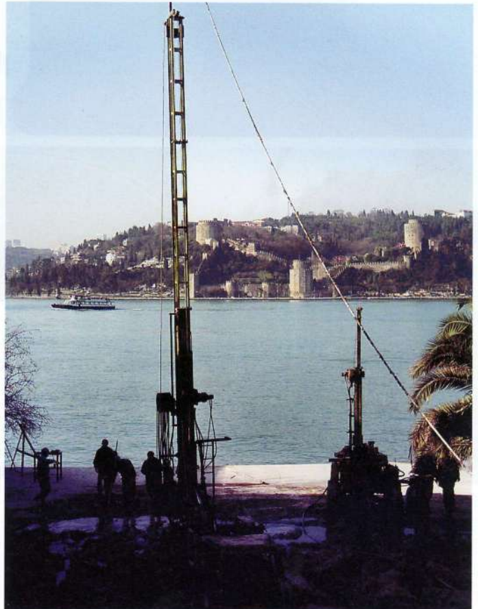
Resim 2: Jet-grout imalatı ve ön delgi işlemi
