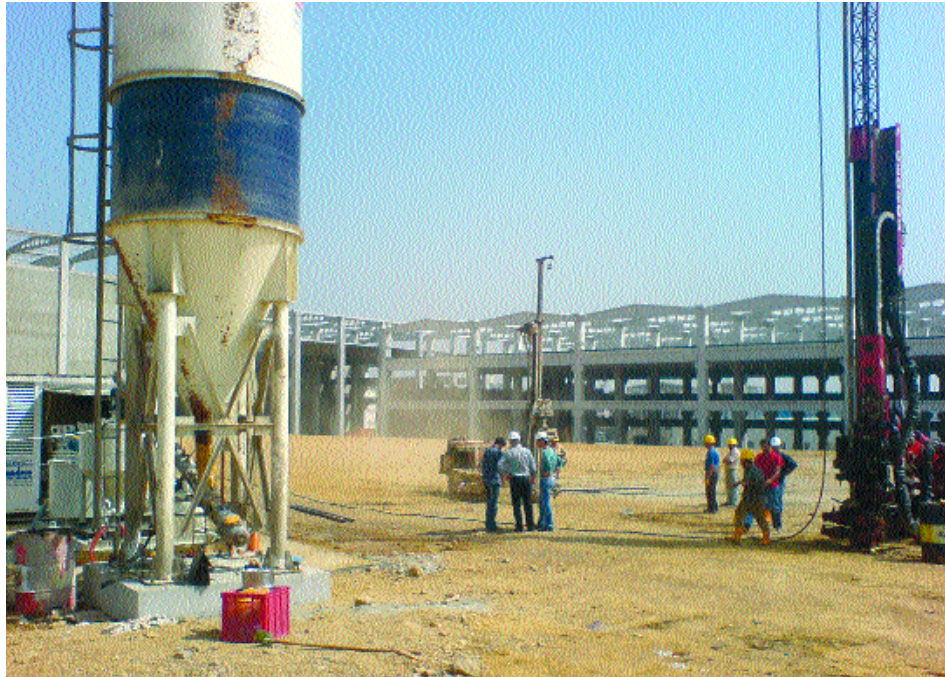
Resim-3: Ön Delgi ve Jet-Grout Uygulamaları
