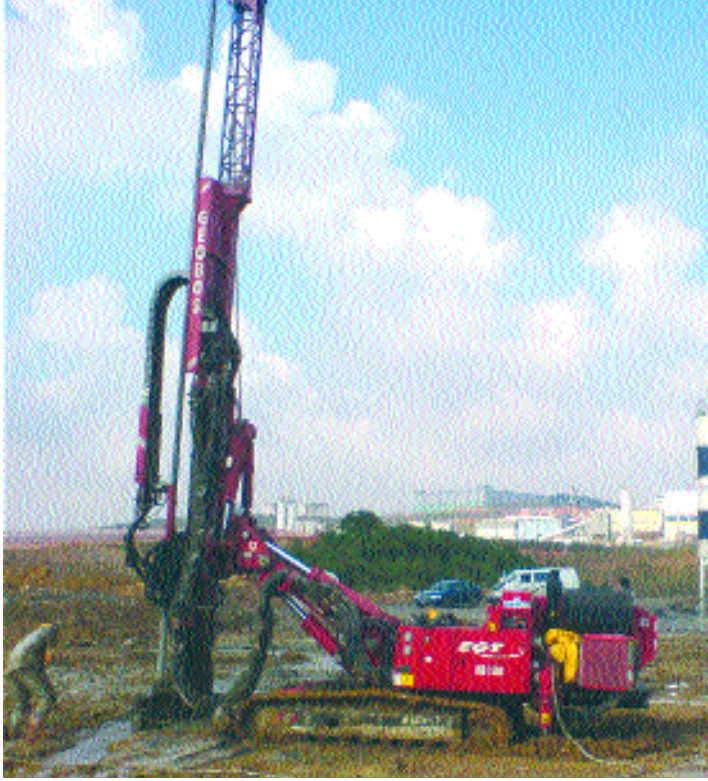
Resim-1: Jet-Grout Deneme Kolonu İmalatı
