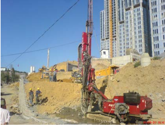
Şekil 7. Jet-Grouting İmalat Görüntüsü
